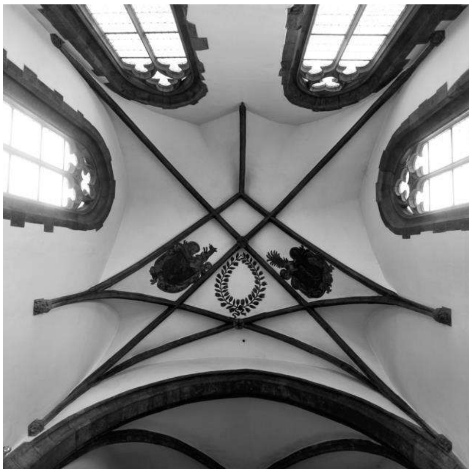
32. Praha , kostel sv. Martina ve zdi, klenba presbytáře
