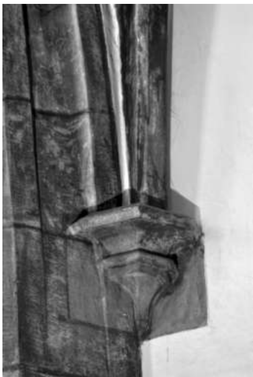
30. Praha , kostel sv. Martina ve zdi, detail jehlancové konzoly v jihovýchodním rohu hlavní lodi
