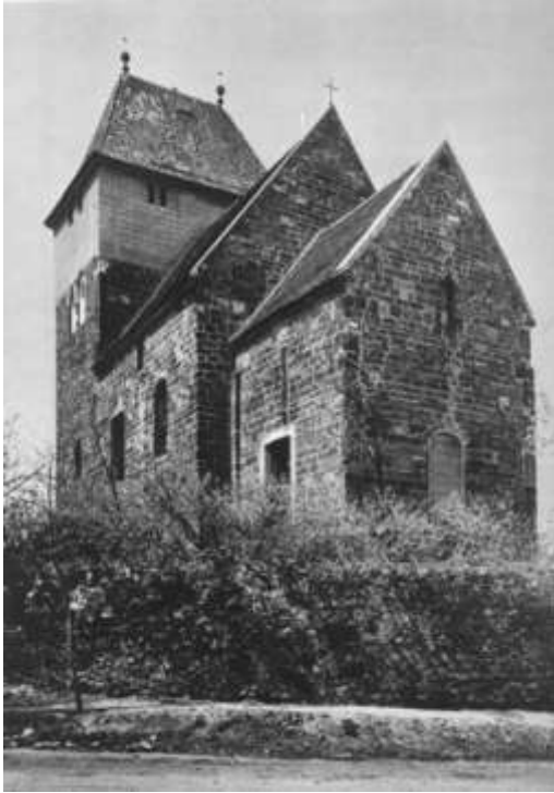
68. Kyje , kostel sv. Bartoloměje, pohled od jihovýchodu
