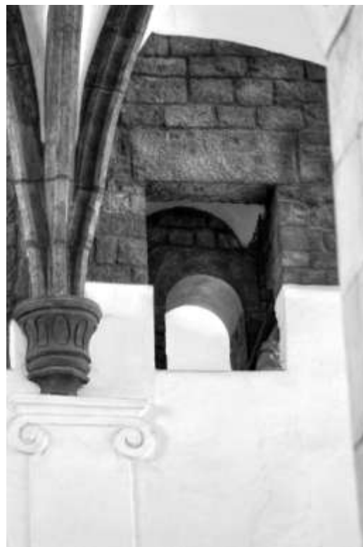
30. Praha , kostel sv. Martina ve zdi, detail jehlancové konzoly v jihovýchodním rohu hlavní lodi
