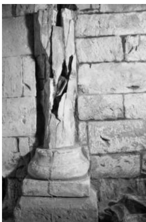
46. Praha , kostel sv. Martina ve zdi, detail původní profilace portálku jižního schodiště
