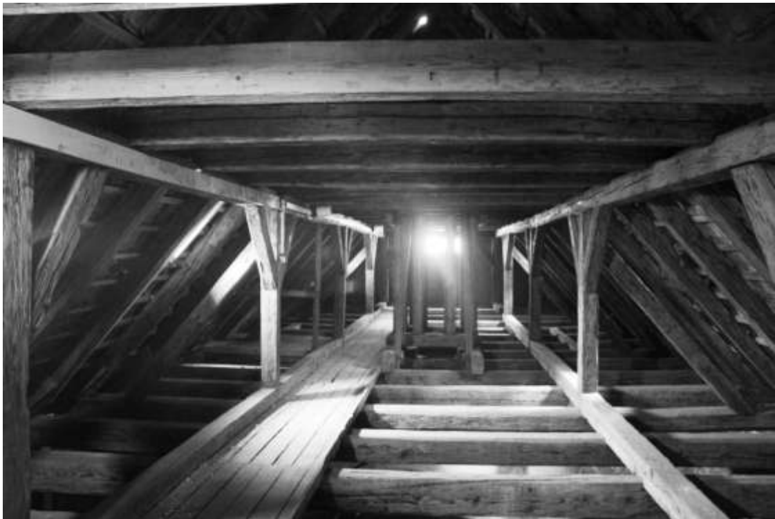
63. Praha , kostel sv. Martina ve zdi, pohled do krovu od západu
