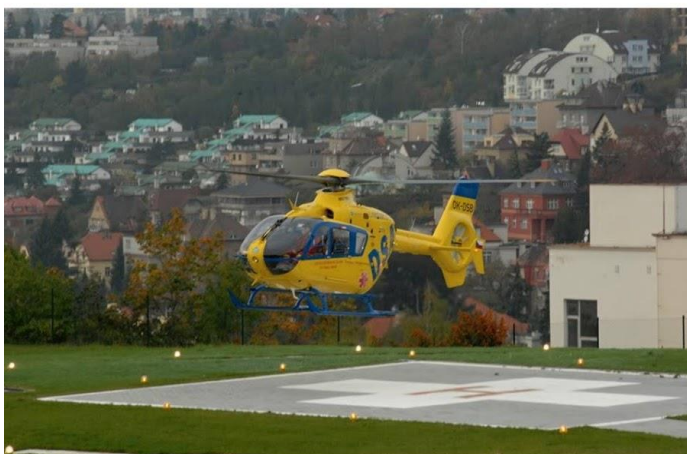
Obr. č. 26 Heliport
