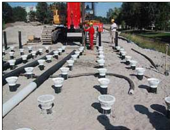
Obrázek 13 - mikropiloty při instalaci [7]
