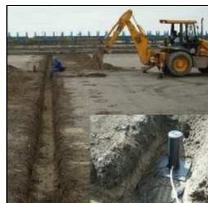
Obrázek 10 - měření sedání pomocí buňky [6]
