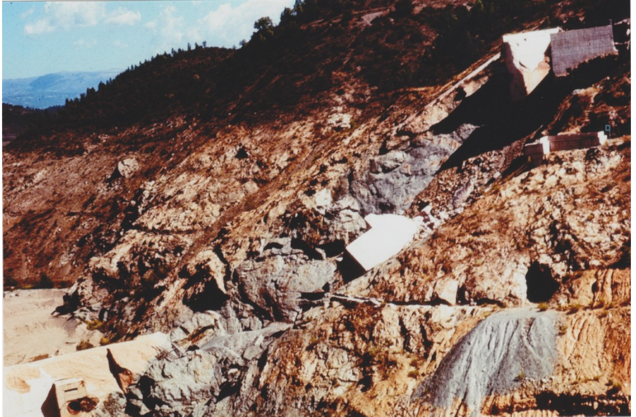
Obr. 4.7 Zřícení přehrady Malpasset – čtyřstěn v hornině na levém břehu (archiv K. Drozd)
