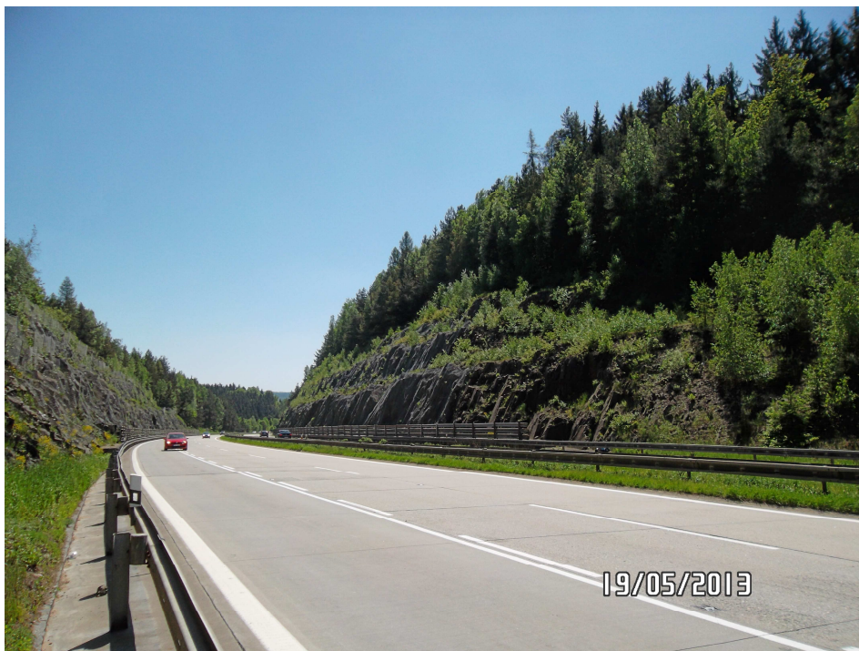
Obr. 9.18 Pohled na Lensedelský zářez směrem od Prahy (na pravo pravý svah zářezu, na levo levý svah zářezu, 05/2013).
