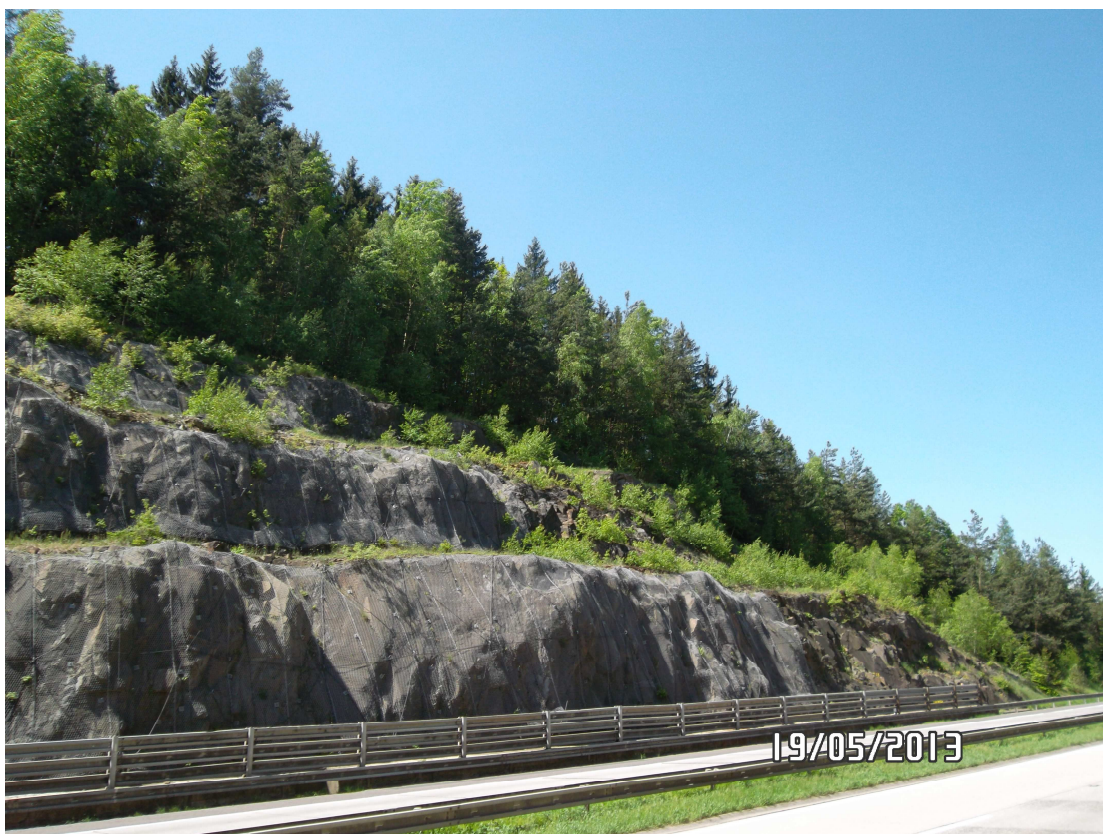
Obr. 9.9 Ocelové pažnice na pravé straně zářezu v současném stavu (05/2013).
