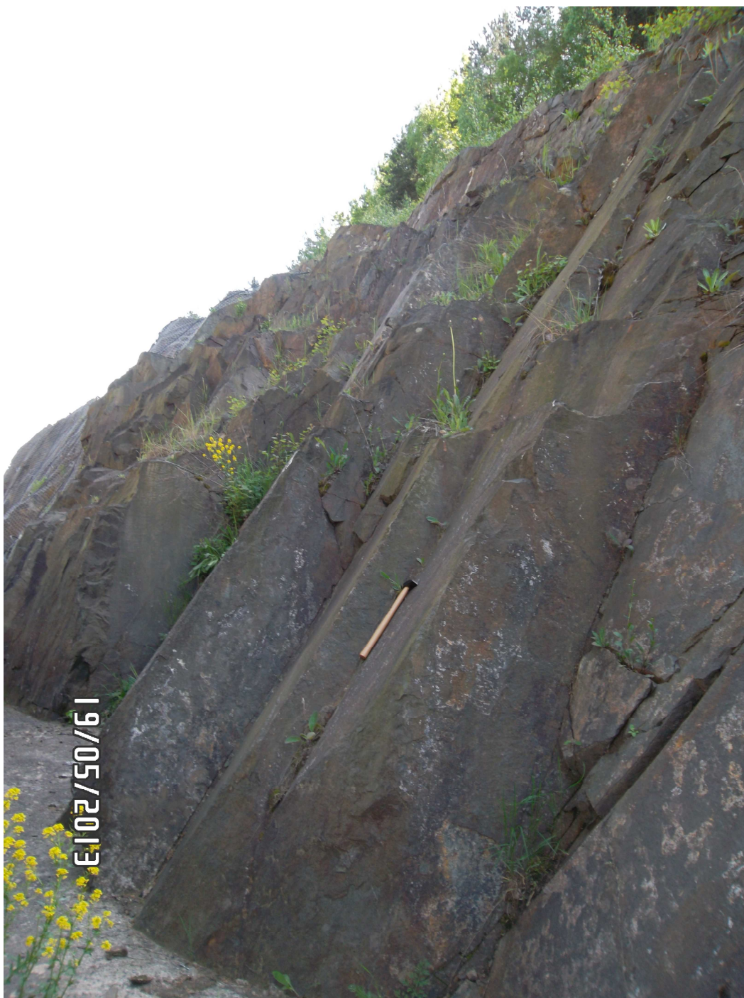
Obr. 9.30 Lensedelský zářez – jeden z hlavních systémů diskontinuit (pravý svah, 05/2013).
