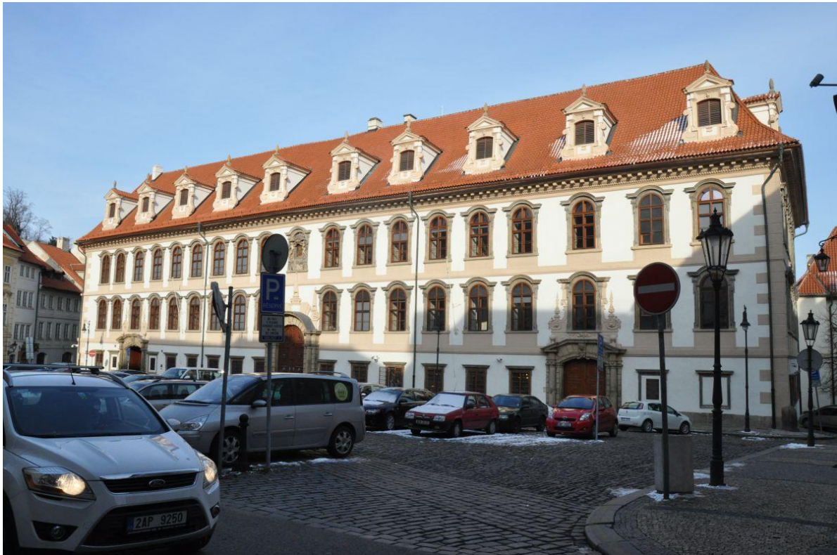
[112] Praha, Valdštejnský palác, hlavní průčelí, pohled od jihu, foto Michaela Ličeníková, 2012
