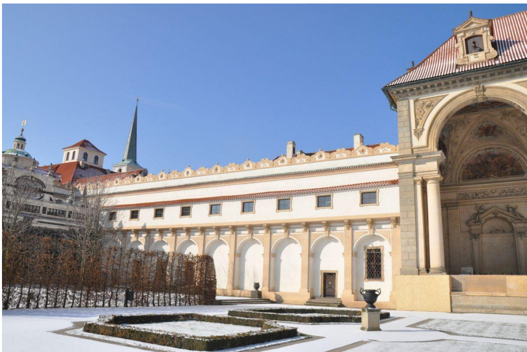
[129] Praha, Valdštejnský palác, pohled přes parter zahrady na salu terrenu a voliéru, foto Michaela Líčeniková, 2012
