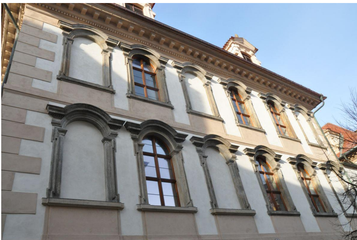
[119] Praha, Valdštejnský palác, boční průčelí, původní tvar okna s celou šambránou, foto Michaela Líčeniková, 2012
