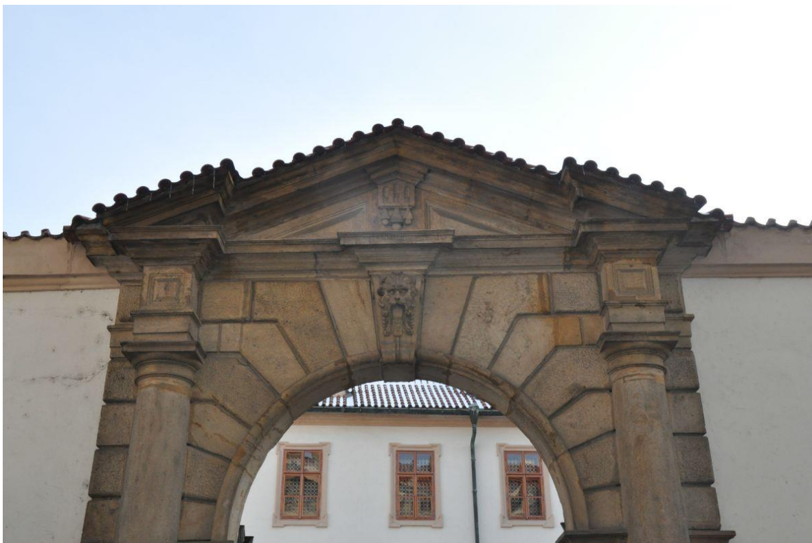
[118] Praha, Valdštejnský palác, portál do Valdštejnské ulice, detail, foto Michaela Líčeniková, 2012
