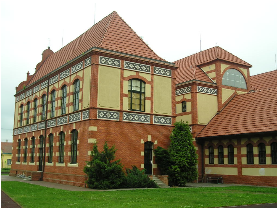
Budovy školy – pohled zezadu
