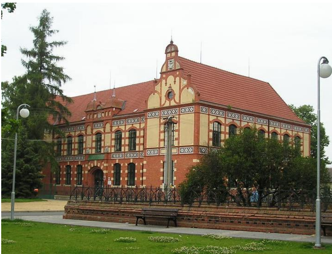
Budova školy v Břeclavi – Poštorné – pohled zepředu
