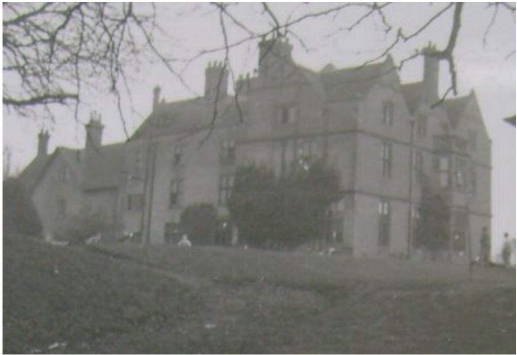
2.4. Budova školy v Hinton Hall
