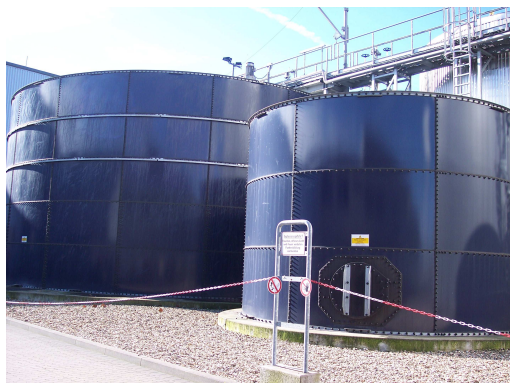
Obrázek 7: Anaerobní stabilizace kalu při čištění odpadních vod (WRAP)
