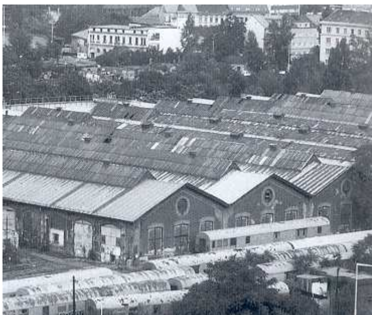
Obrázek 10: Železniční areál Zdroj: Beran, L., Valchářová, V.: Pražský industriál, s. 56
