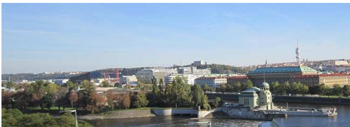
Obrázek 29: Štvanice s elektrárnou
