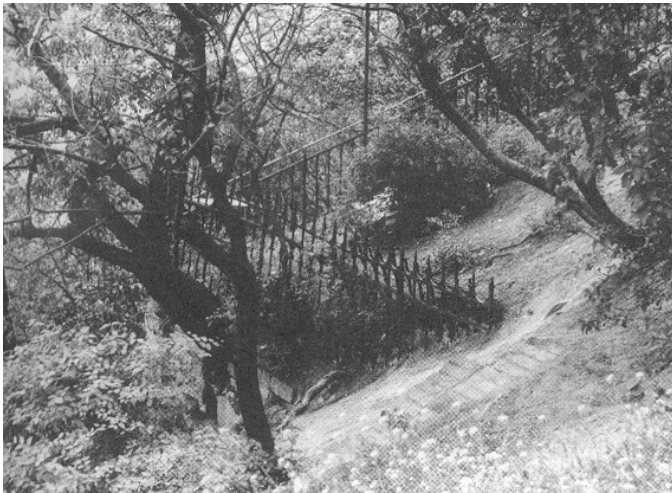
Obrázek 14: Jediný pozůstatek stanice lanové dráhy Zdroj: Hlušíčková, H a kol.: Technické památky v Čechách, na Moravě a ve Slezsku, III. díl, s. 211
