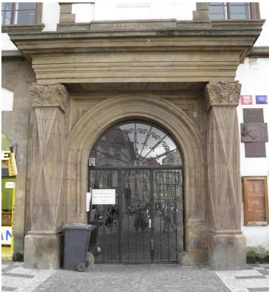
[18] Praha, Staré Město, portál domu U Kamenného beránka, před 1531, celkový pohled.
