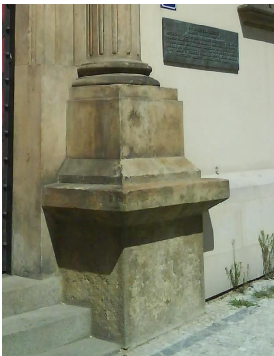
[16] Praha, Nové Město, portál Novoměstské radnice, mezi 1520 – 1526, sokl.
