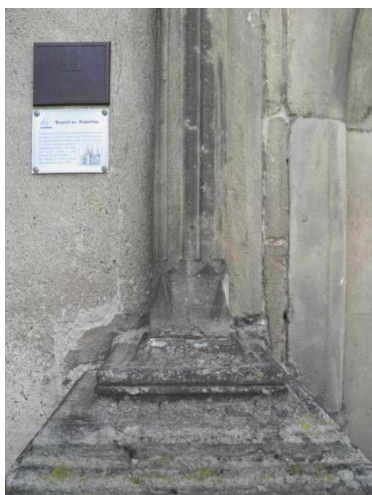
[36] Chrudim, západní portál kostela sv. Kateřiny, mezi 1514 – 1536, spodní část dříku.
