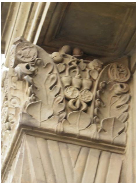
[22] Praha, Staré Město, portál domu U Kamenného beránka, před 1531, detail levé hlavice,
