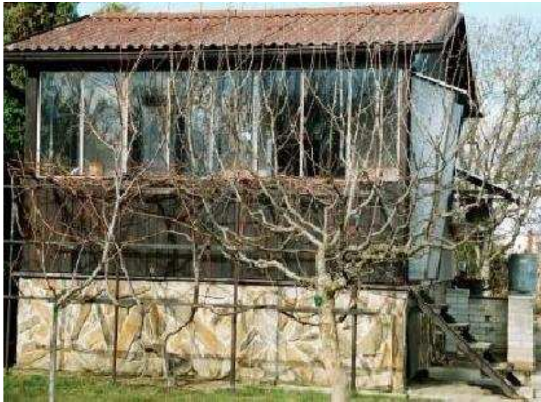
Obr.1: Zahrádkářská chata v zahrádkářské osadě – okolí Prahy
