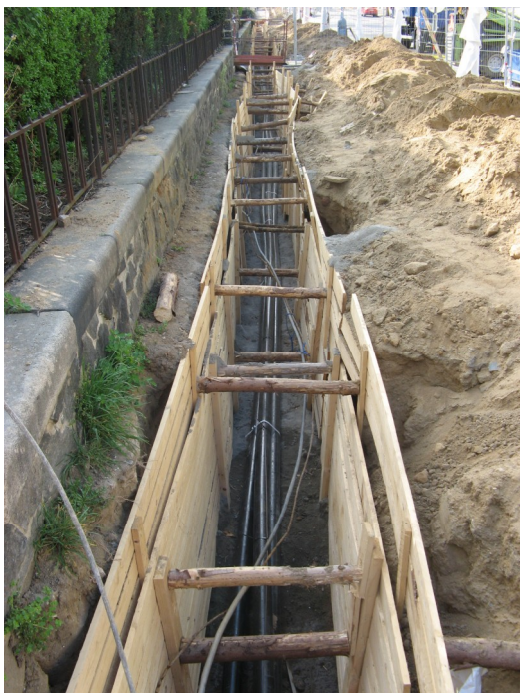
Obr. 3. Výkop ve Studničkově ulici
