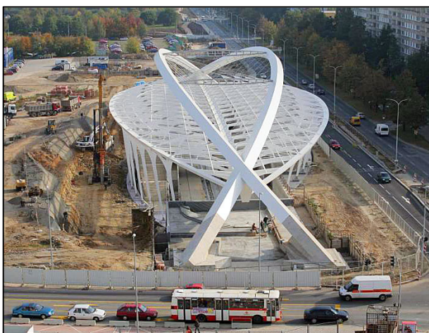
Obrázek 30: stanice Střížkov svou konstrukcí připomíná velrybu
