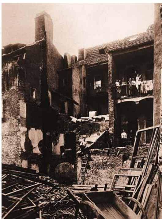
Židovské domy určené k demolici v rámci asanace. Foto J. Eckert
