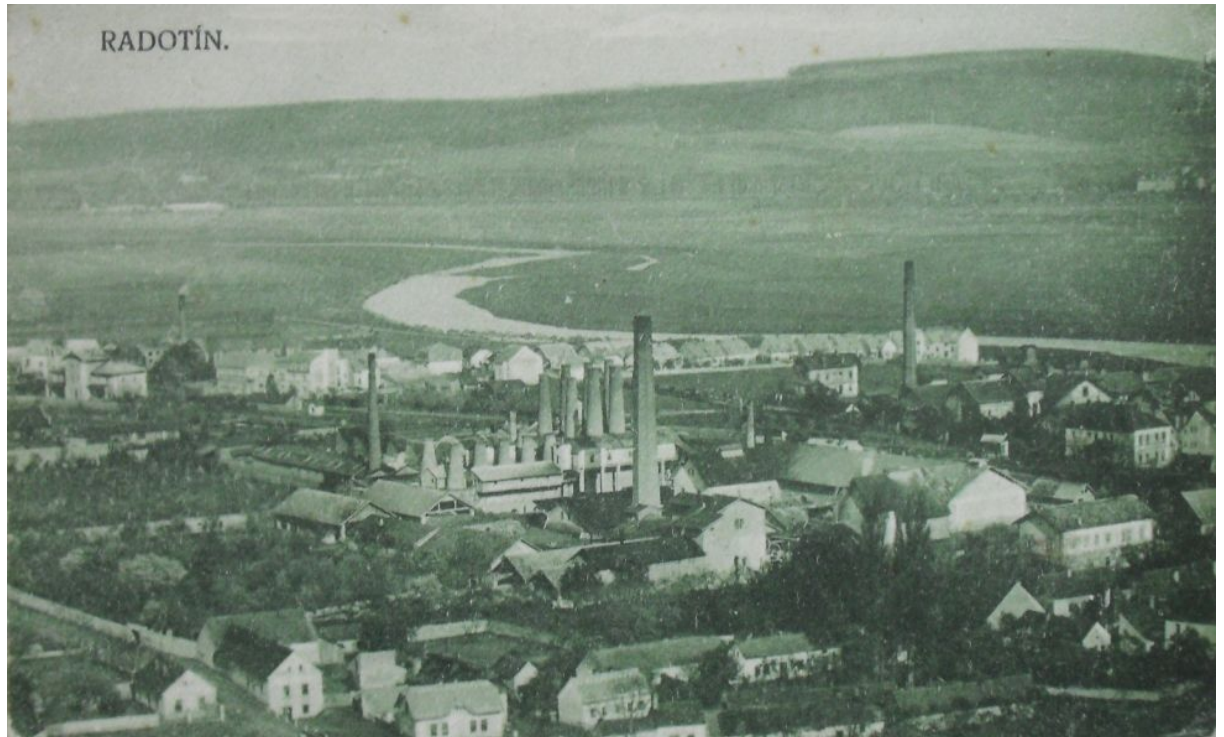
Obrázek 12. Pohlednice Radotína z roku 1920. Cementárna Radotín je komplex budov s komíny hned za radotínskou vápenkou (budova uprostřed s jedním komínem)
