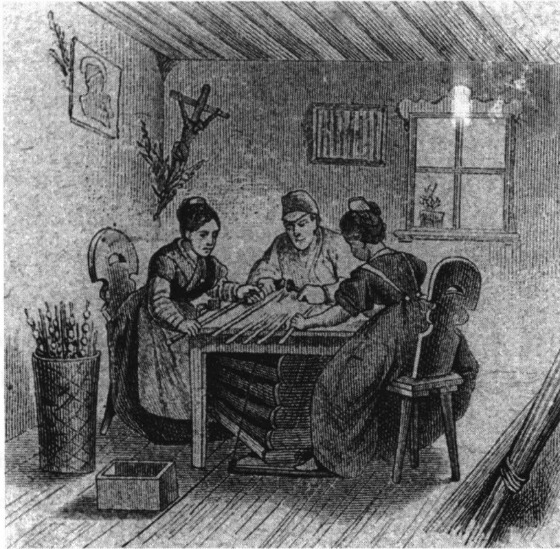
Obrázek 24: Práce u stolu nad kahanem
