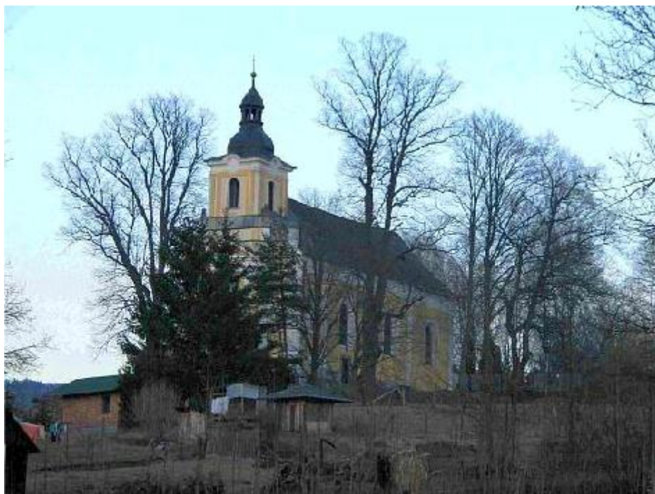
Obrázek . 31 Kostel v Nemanicích po opravě (foto Domaflický deník).
