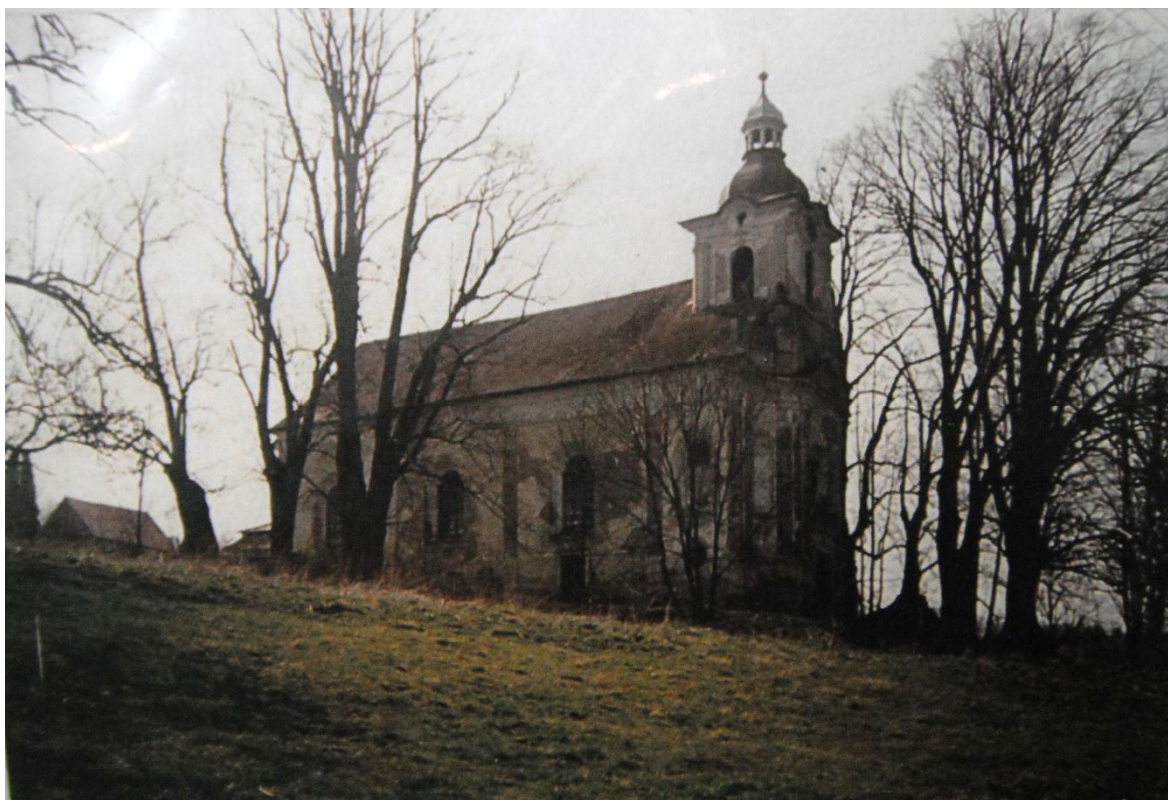
Obrázek . 30 Kostel v Nemanicích v roce 1990 před opravou.
