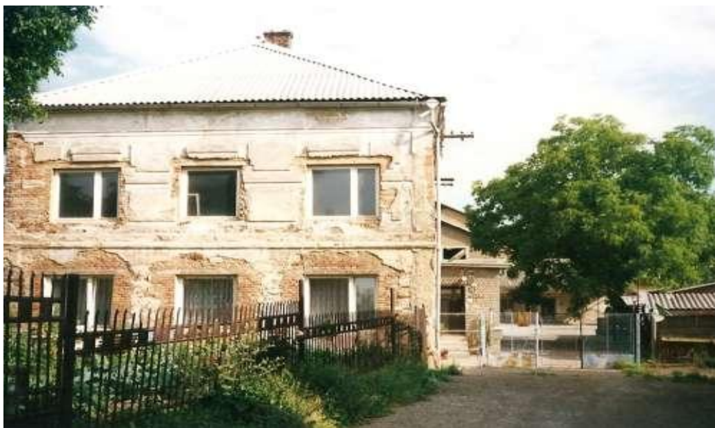
Současný stav budovy bývalého pivovaru Čeňka Šillingera
