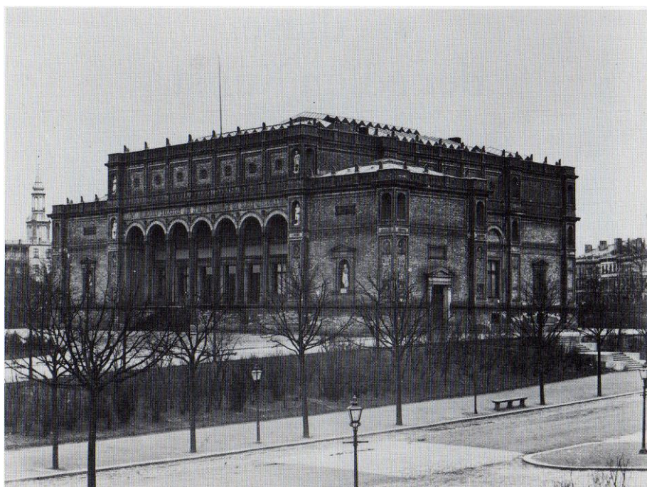
Obr. 4) Západní fasáda Kunsthalle, pohled z Glockengießerwall před rokem 1886 (Foto: G. Koopmann)
