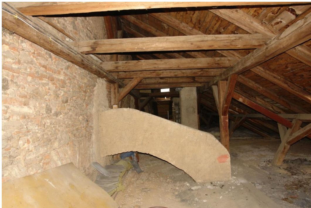
obr. 19 – půda s kouřovodem
