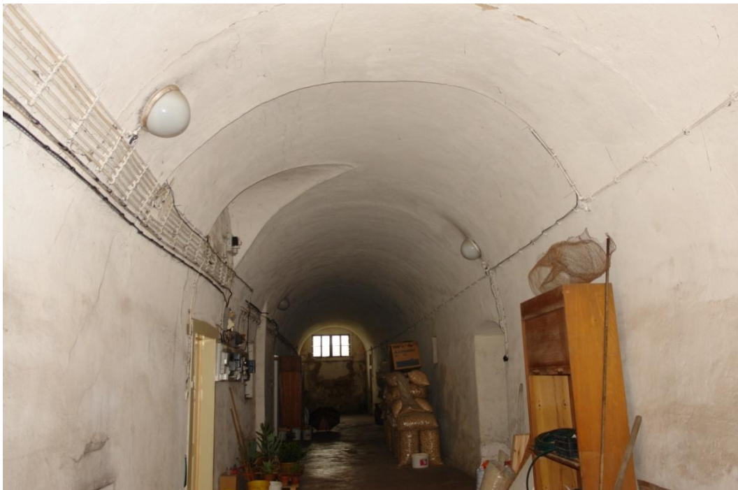
obr. 4 – první suterén (podélná chodba s valenou klenbou)
