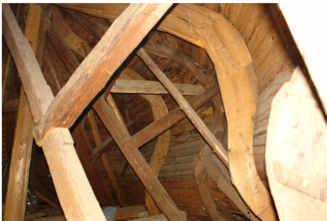
obr. 20 – střecha, zastřešení věže s dřevěným krovem
