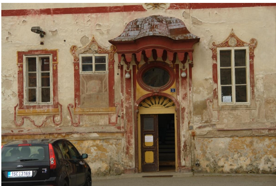
obr. 26 – vstup do zámku ze severní strany
