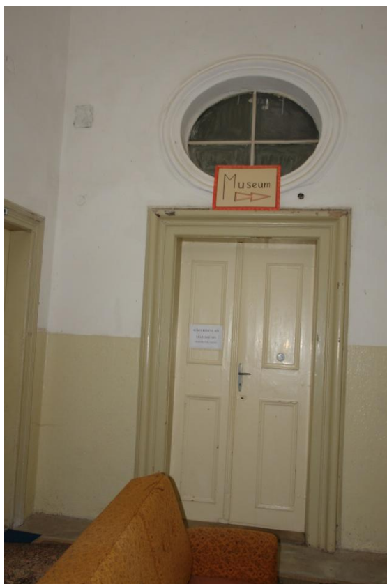
obr. 12 – chodba v přízemí, dveře na východní straně s eliptickým nadsvětlíkem
