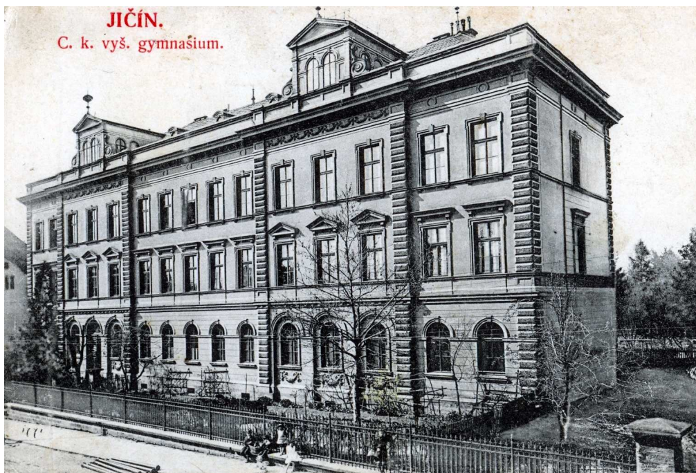
Obr. č. 15 Budova jičínského gymnázia (postavena roku 1883)
