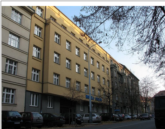
Příloha č. V – Budova bývalé Koleje Akademického domu v Terronské ulici
