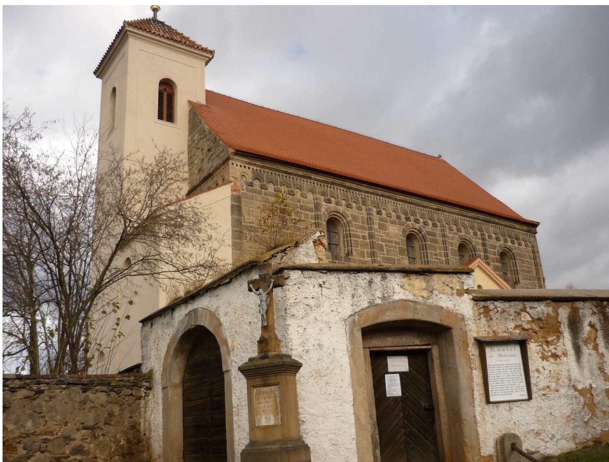
37. Potvorov, kostel sv. Mikuláše, pohled na kostel z jihu
