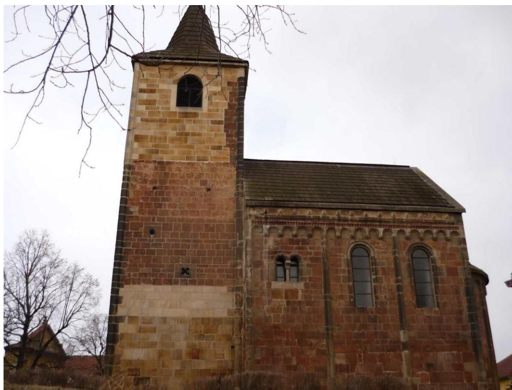
45. Vroutek, kostel sv. Jakuba Většího, pohled na kostel z jihu
