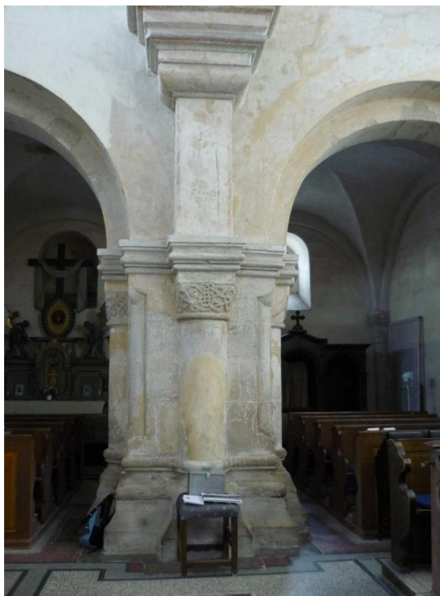
38. Potvorov, kostel sv. Mikuláše, pilíř podírající tribunu
