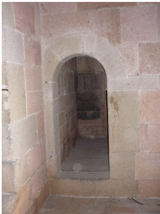
47. Vroutek, kostel sv. Jakuba Většího, portál vedoucí na schodiště v síle zdi věže
