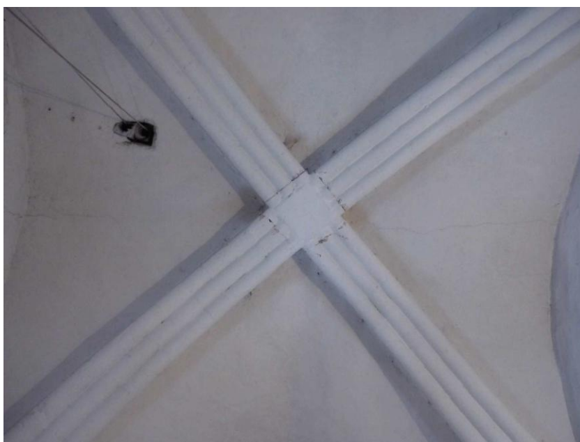
33. Kostomlaty pod Milešovkou, kostel sv. Vavřince, klenba presbytáře
