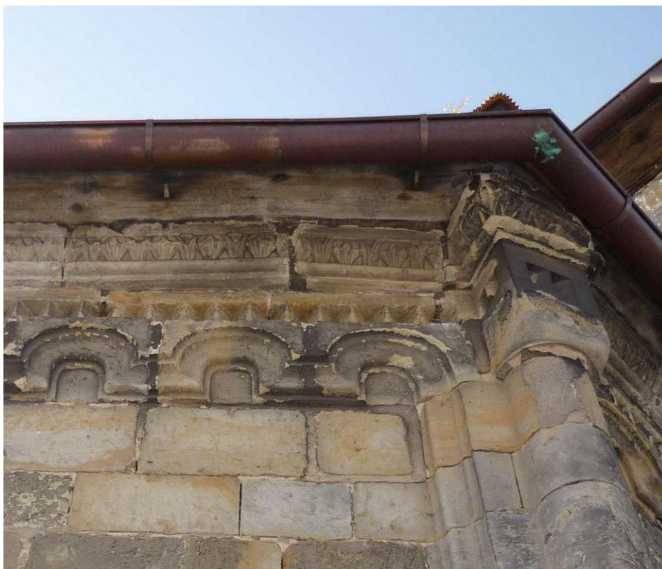
12. Vinec, kostel sv. Mikuláše, detail hlavní římsy na apsidě kostela
