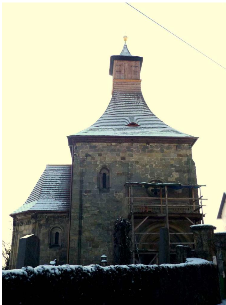
42. Vinec, kostel sv. Mikuláše, pohled na kostel ze severu
