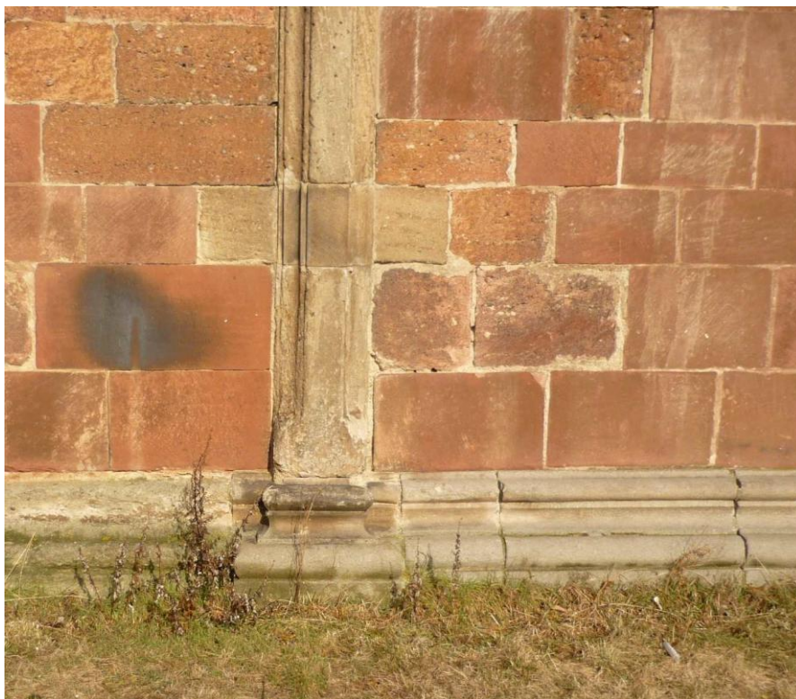
1. Vroutek, kostel sv. Jakuba Většího, detail stěny kostela a lizény
