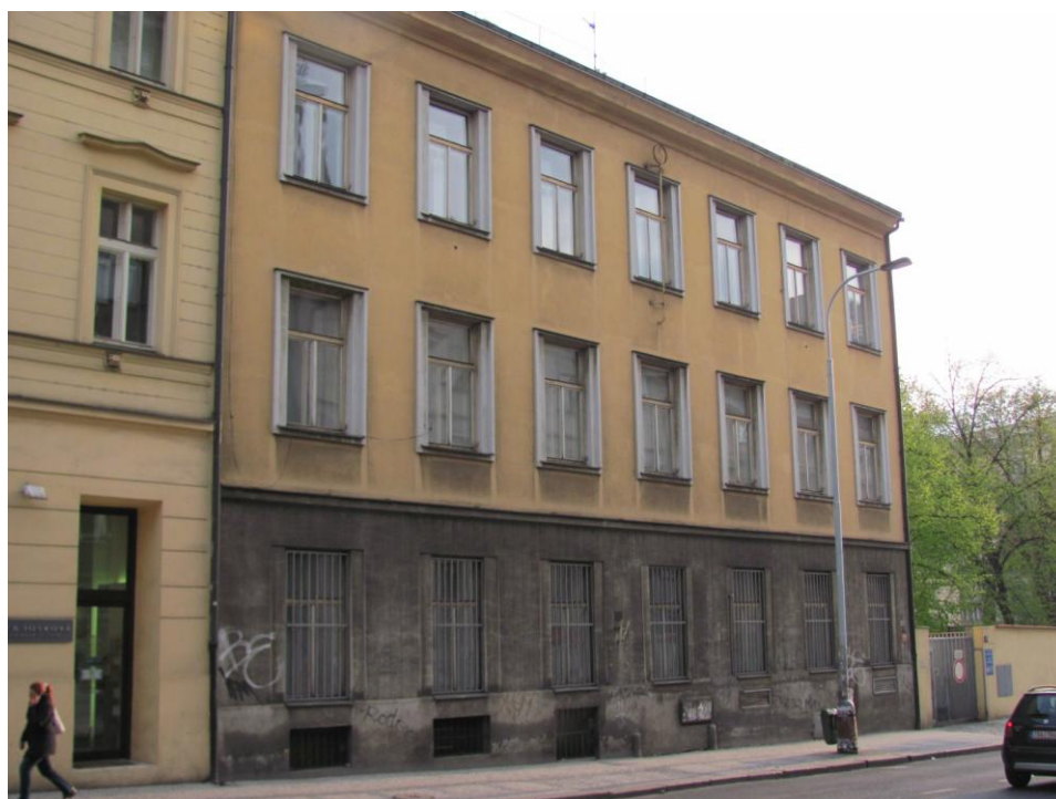
obr. 26 – boční pohled na budovu bývalé Vyšší ošetrovatelské školy, otevřené v roce 1946; nyní zde sídlí Foniatická klinika VFN; Žitná ul., Praha 2 (vlastní foto, 19. 04. 2012)
