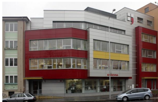
Budova pobočky Ruská (Domu čtení)
