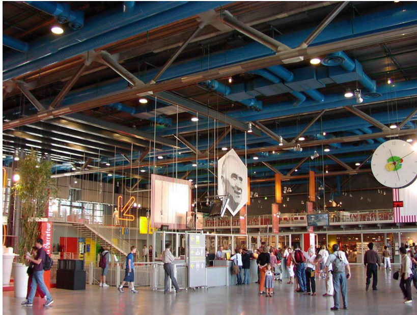
příklad instalace v Centre George Pompidou v Paříži
