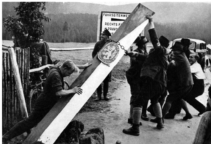
Bourání hraničního sloupu
