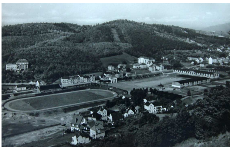
Stadion v Ústí nad Labem
