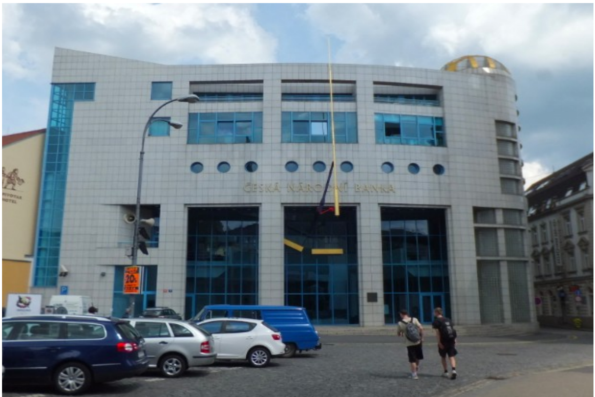
43. Pohled na hlavní průčelí. Současný stav.
