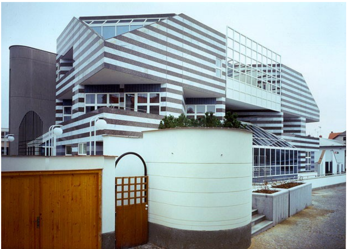
62. Pohled na jihovýchodní roh banky.
