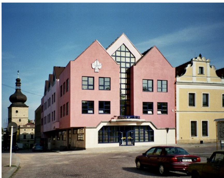
88. Pohled na průčelní fasádu a fasádu do ulice Vladislavova.
