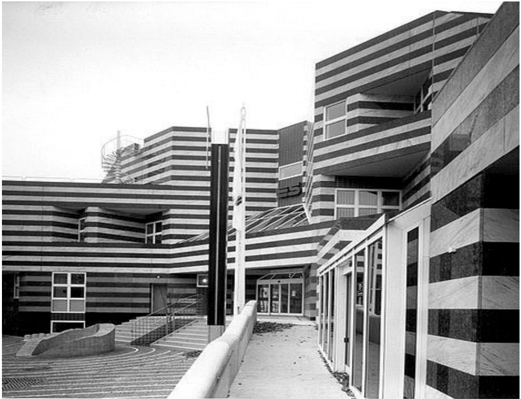
61. Vladimír Štulc, Jan Vrana: Česká spořitelna v Jindřichově Hradci, 1992-1994. Pohled na hlavní fasádu se vstupem z ulice Nádražní.
