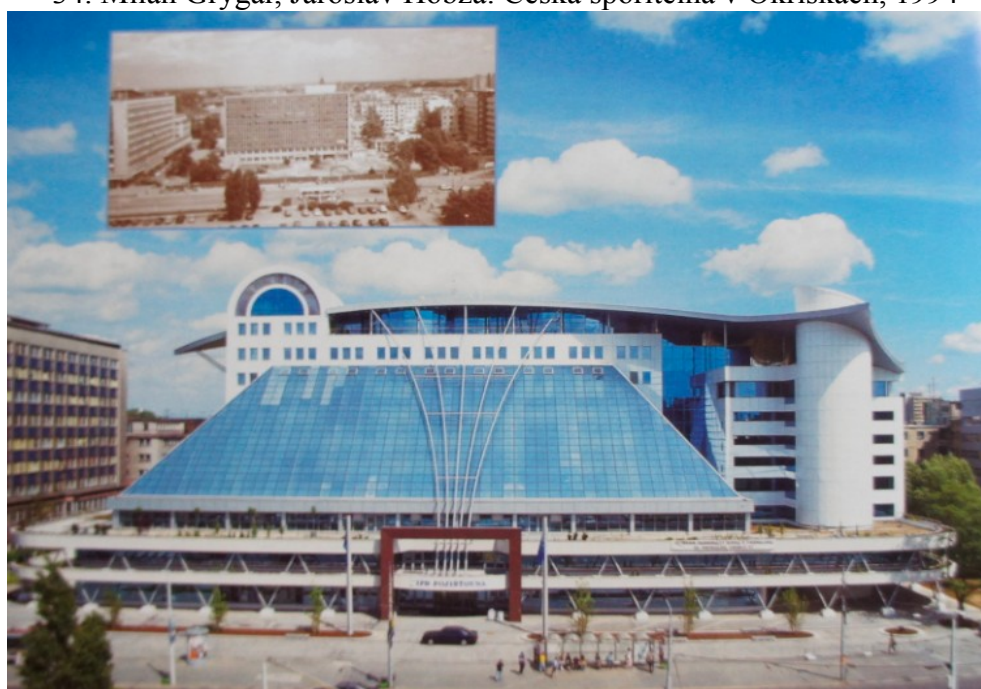
35. P. Macas, S. Macas: Rekonstrukce IPB Pojišťovny v Pardubicích, 1998 – 2000.
