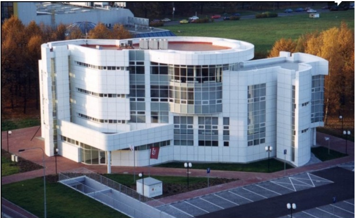
86. Pohled na jižní fasádu.
