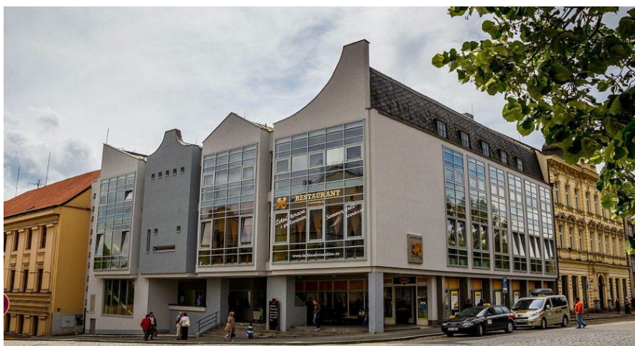
23. Restaurace Dubina v Domažlicích po rekonstrukci fasády do původního stavu firmou Top Tank, 2011.
