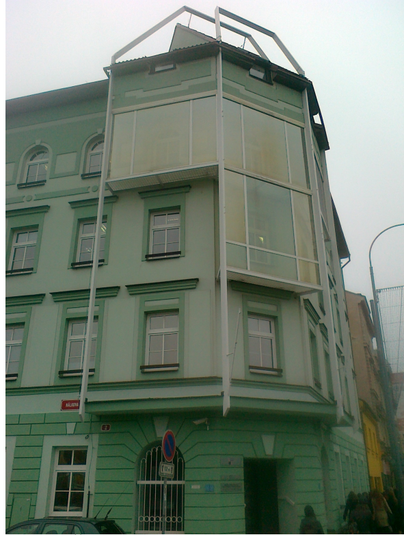
16. Budova České inspekce životního prostředí v Plzni.
