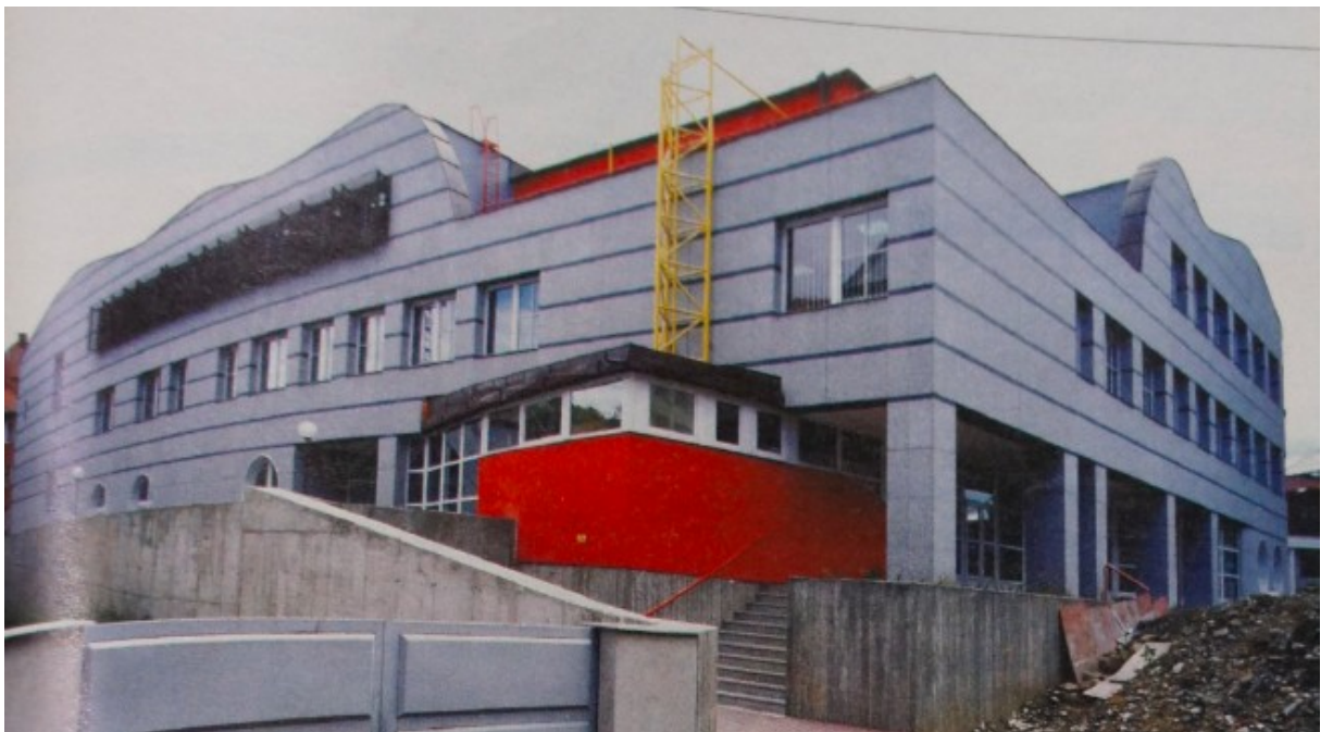
69. Pohled na zadní východní fasádu.
