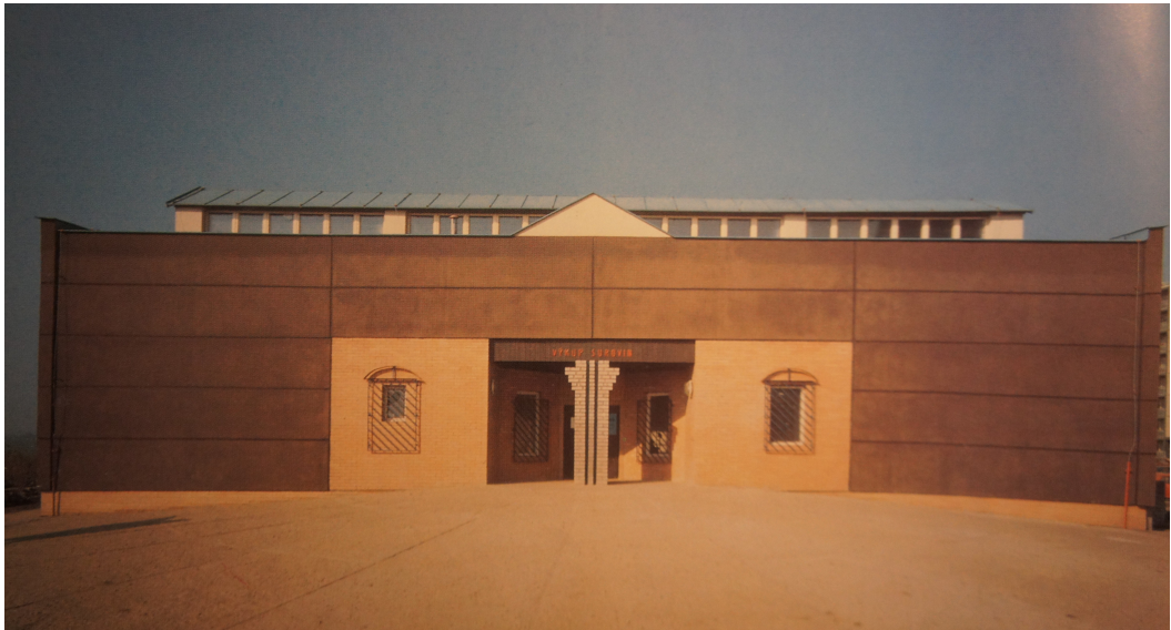
1. Tomáš Brix: Budova sběrných surovin na sídlišti Lužiny v Praze, 1977 – 1984.
