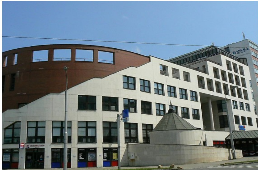
59. Pohled na trhlínu schodiště.
