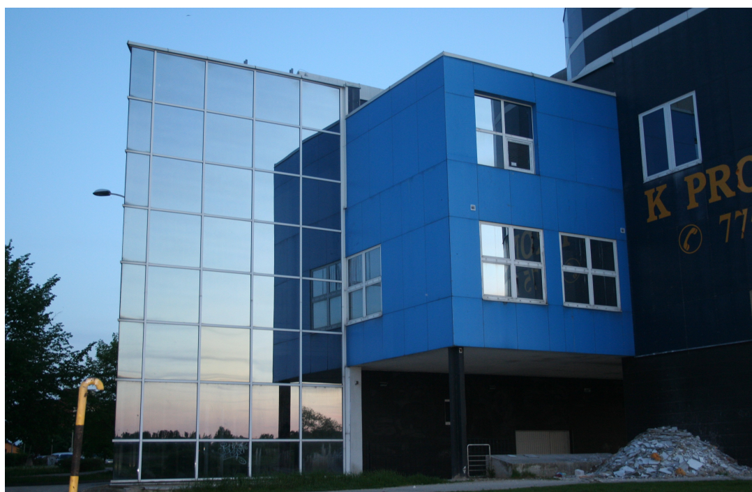
78. Reflexní zrcadlení kubické části stavby na skleněný plášť fasády.
