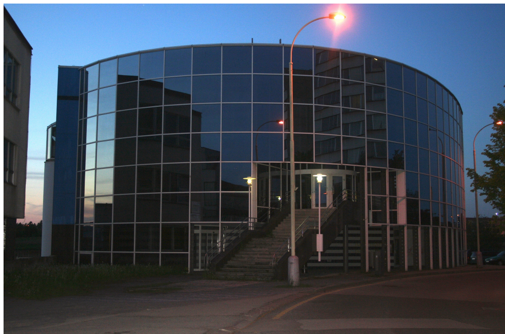
73. Pohled na jižní vchodovou fasádu.
