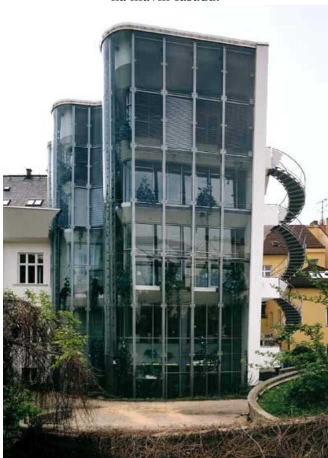
39. M. Krupauer, J. Střítecký: Rekonstrukce a přístavba ČSOB Lannova v Českých Budějovicích, 1993-1995. Pohled na hlavní přístavbu.
