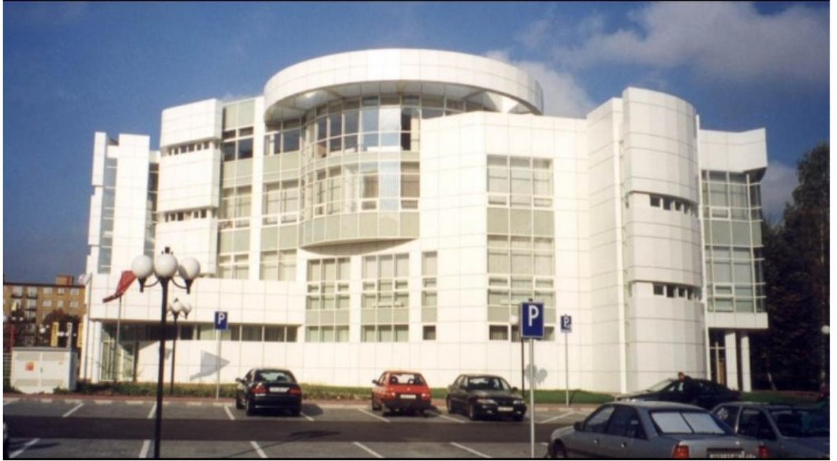
85. Evžen a Roman Kuba: Komerční banka v Ostravě, 1999. Pohled na severní fasádu.
