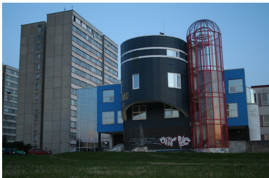
72. Pohled na severní průčelí, současný stav.
