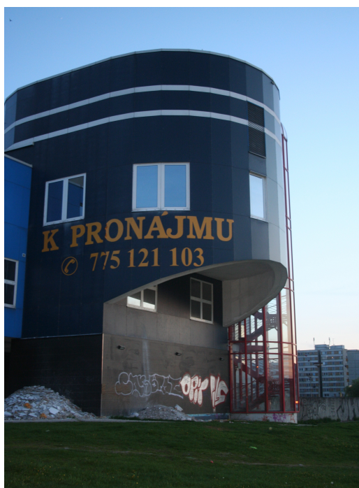
76. Pohled na střední část severní fasády.
