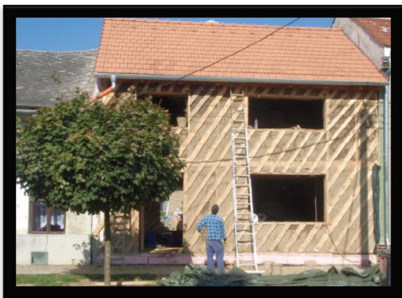
Obrázek č. 1: Stavba v Ivanovicích
