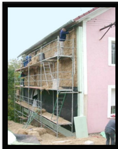
Obrázek č. 2: Stavba v Mnichovicích
