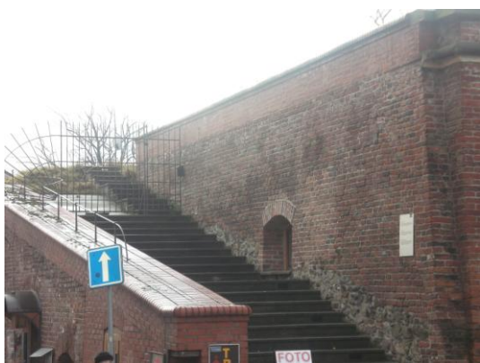
Obrázek č.40 schodiště Vodní kasárna Olomouc 45
