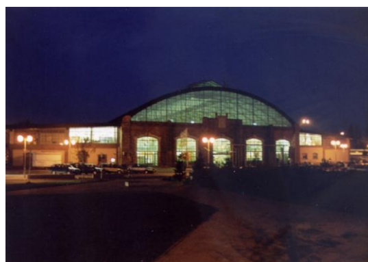
Obrázek č.34 budova jatek po rekonstrukci 38
