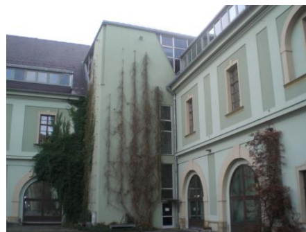
Obrázek č.45 rohová věž na nádvoří zbrojnice 50
