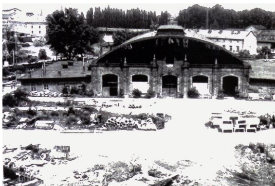
Obrázek č.33 budova jatek před rekonstrukcí 37
