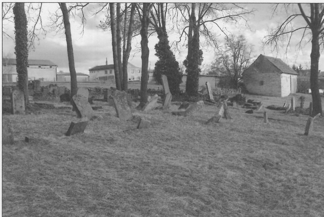
I. celkový pohled na hřbitov, stav v roce 2006
