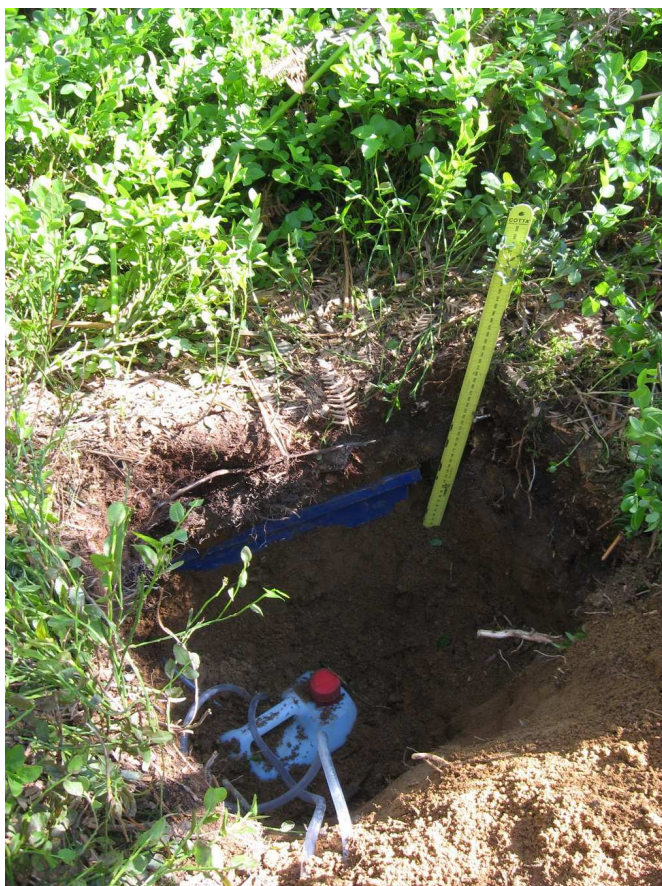
Obr. 6.2.: Instalace lyzimetru LB
