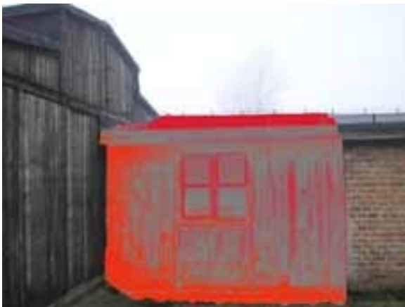
Obr. 3* ) červen vyzna enou ástí byl po válce propojen barák N°41 (vlevo) s bunkrem (vpravo).
