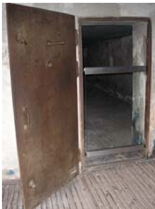
Obr. 26*) Komora A v roce 2010 s moderní instalovanou sklen nou tabulí ve vchod .
