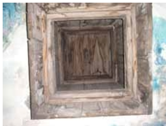
Obr. 14*) Odvzdušňovací otvor provizorní komory v mužském sprchovacím baráku (pohled zevnitř).
