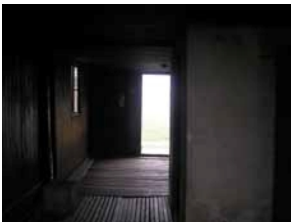
Obr. 5* ) Interiér spojovacího koridoru s pohledem na „esesmanskou kabinu“ (vpravo) mezi komorami v bunkru.
