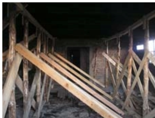
Obr. 36*) Reparační práce probíhající uvnitř.
