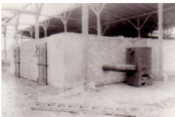
Obr. 17§) Poválečný snímek Bunkru. Stěchu nad stavbou zničila ve druhé polovině čtyřicátých let série hurikánů. Na konci let padesátých měla být obnovena, ale namísto toho dostal stěchu vlastní cihlový kvádr (viz obrázky 15 a 16 nahoře), který byl spojen s barákem N°41.
