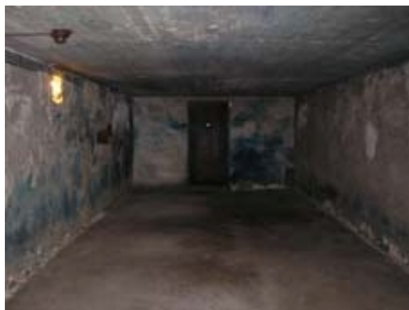
Obr. 24*) Tatáž komora o t i roky pozd ji. Všimn te ná si, že zadní dve e jsou zcela dov ené a zajišt né. Z komory byla odstran na typická tabule ze šedesátých let.
