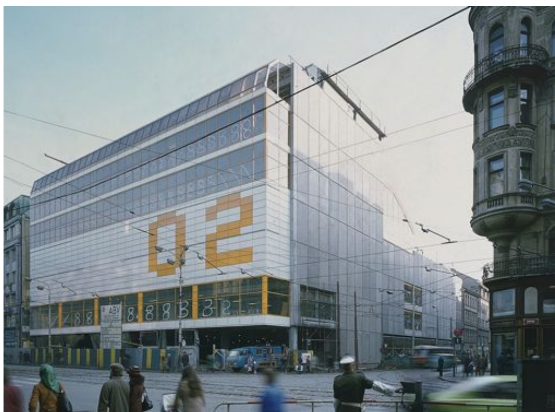
67. Stavba těsně před dokončením ještě jako 02, 1975, foto: Archiv Muzea architektury a stavitelství NTM
