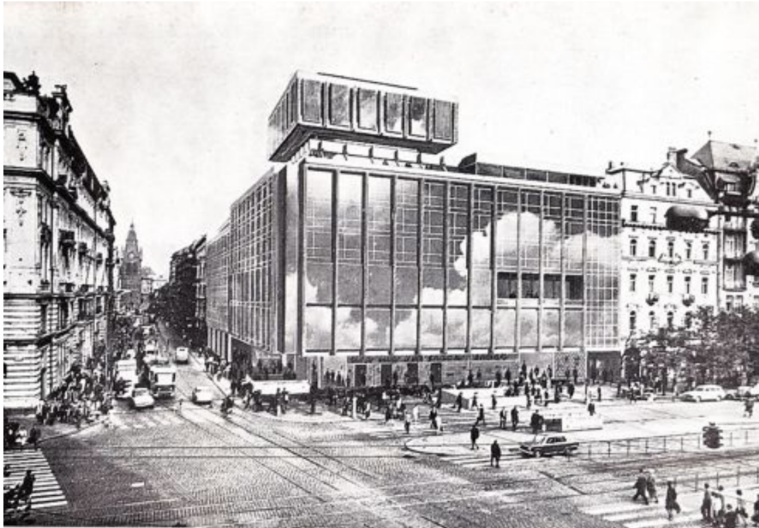
47. První verze projektu, kde fasáda měla být pojmuta jako souvislá celoskleněná plocha, reprodukce: Obrana architektury 48'68 (kat.výst), Praha 1968
