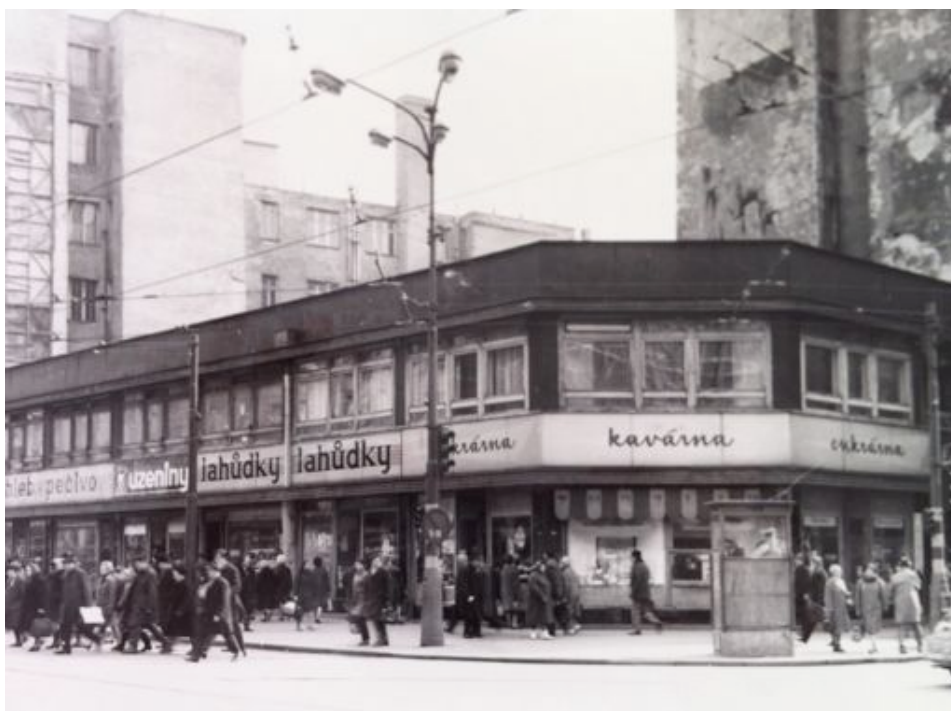
61. Nároží Národní třídy a Spálené ulice, dřevěná provizorní stavba na místě Šlikova paláce, fotografie J. Vopravil, před stržením 1969, archiv Stavebního úřadu Prahy 1
