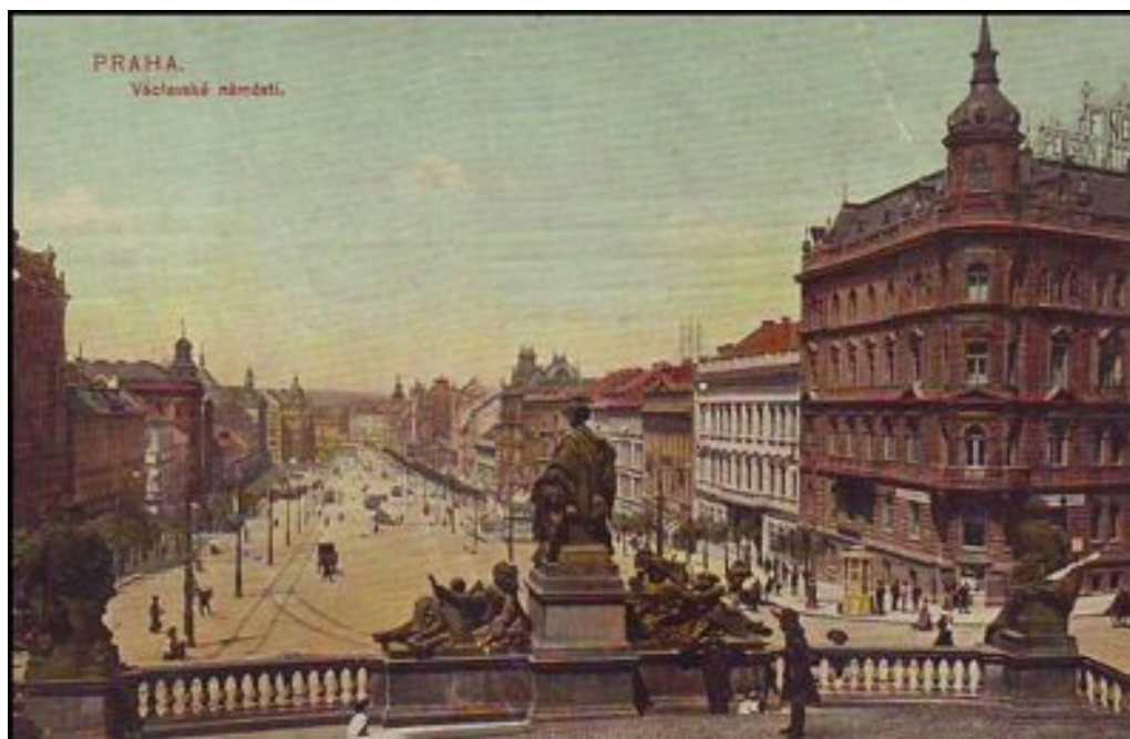
2. Pohled na Václavské náměstí z terasy Národního muzea s rohovým domem "Zlatá Hvězda" zničeným roku 1945, kolorovaná pohlednice 1908
