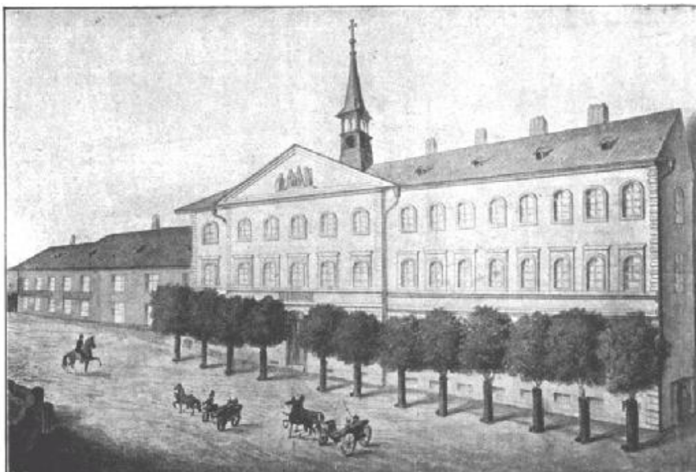
Obrázek č. 1 Klárův ústav slepců, budova v roce 1848
