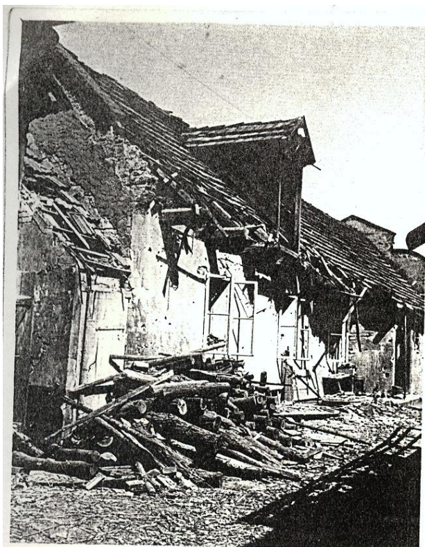
24. Poškozené domy po náletu na Byšice
