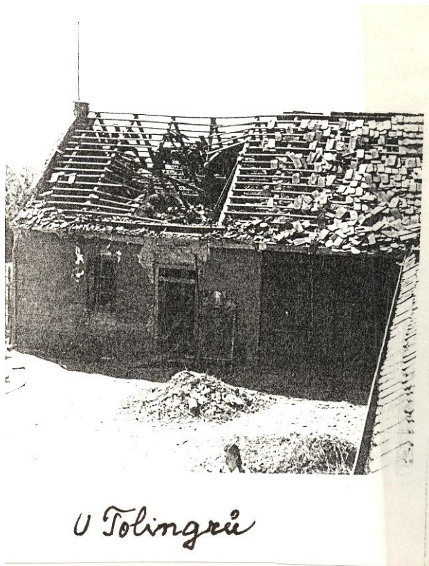
26. Poškozené domy po náletu na Byšice
