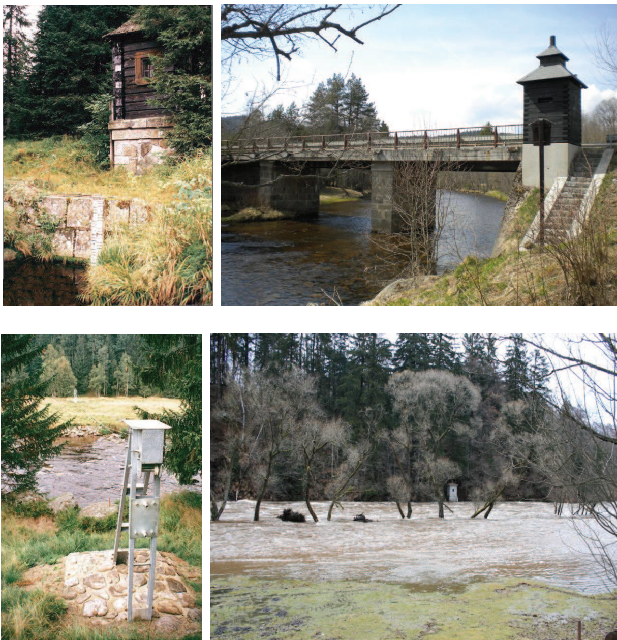
Obr. 21 Limnigrafické stanice v zájmovém povodí (zleva doprava): a) limnigrafická budka v profilu Vydra-Modrava, B) limnigraf v profilu Křemelná-Stodůlky, c) řečiště v profilu Vydra-Modrava, d) limnigraf v závěrovém profilu Otava-Rejštejn během extrémní povodňové události v březnu 2008 (foto: autor)
