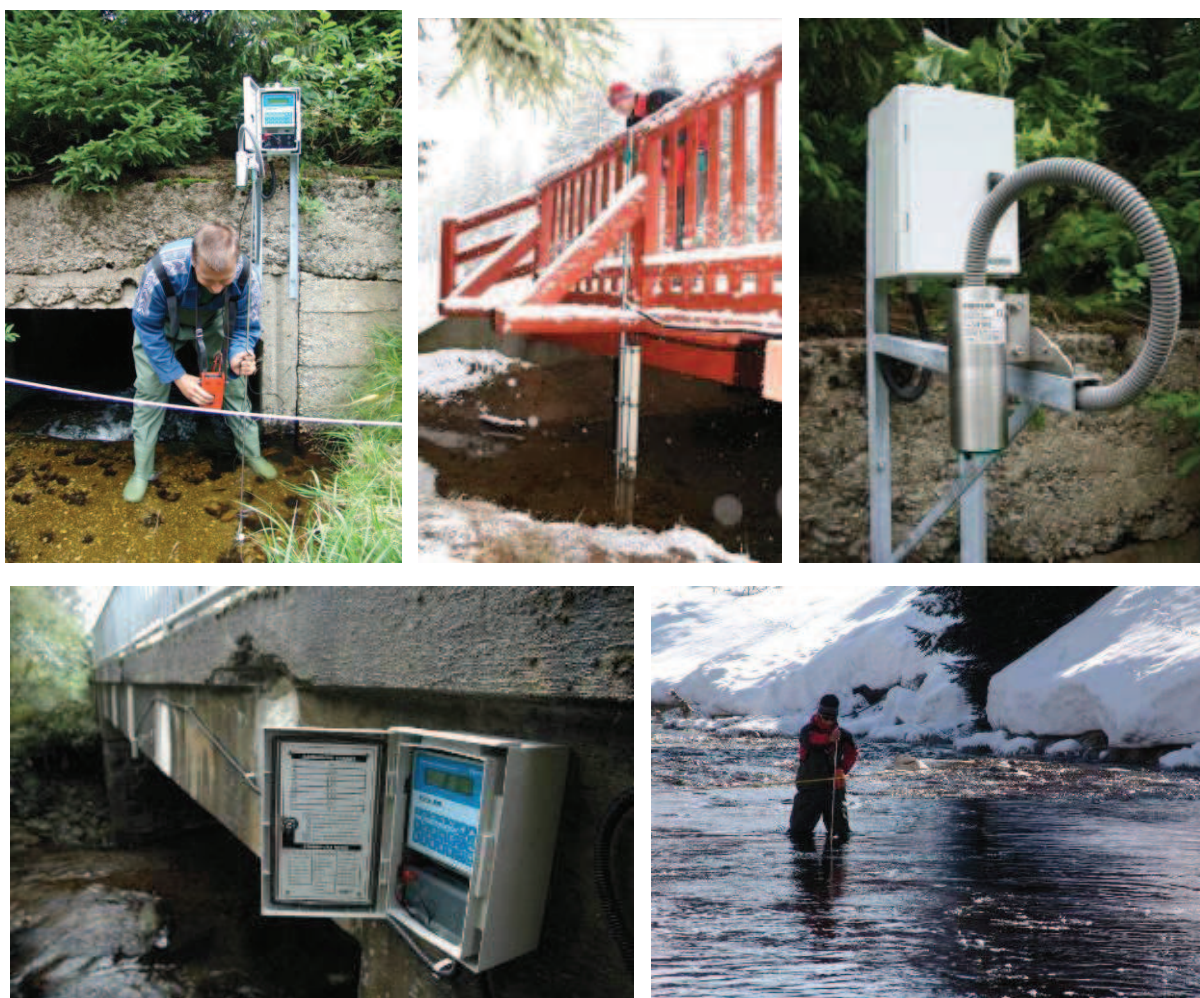
Obr. 25 Automatické stanice (zleva doprava): a) hladinoměrné zařízení a hydrometrování v profilu na Ptačím potoce, b) tlakové čidlo a sensory pro monitoring fyzikálně-chemických parametrů (Černý potok), c) ultrazvukové čidlo (Ptačí potok), d) řídicí jednotka typu M-4016 (Prášilský potok), e) hydrometrování v závěrovém profilu Roklanského potoka (foto: autor)
