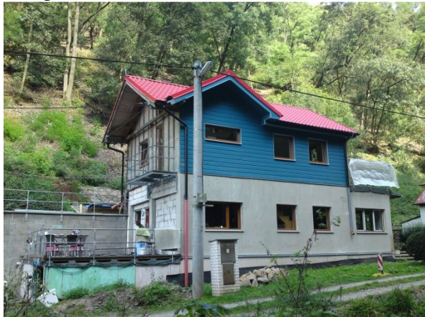
Fotografie č. 9: Přestavba ODB v Jarovském údolí
