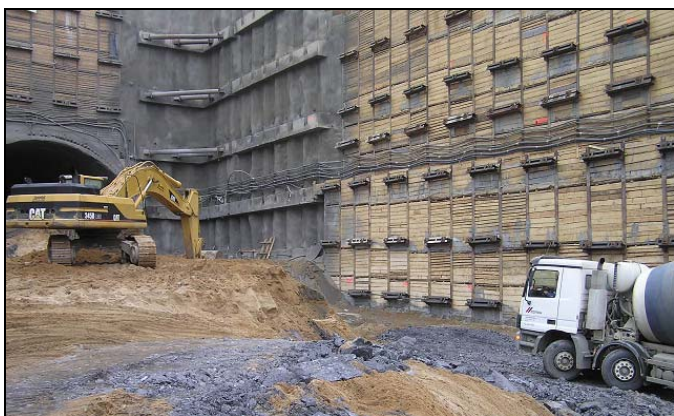
Obr. 2.4 Záporové pažení s převázkami aplikované na stěně jámy, v pozadí pilotová stěna s několika kotevními úrovněmi (Skanska).
