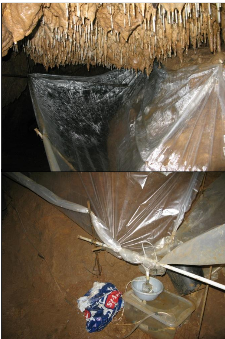
Obr. 10. Systém sběrných igelitů, odvádějících skapovou vodu do Jezírka
