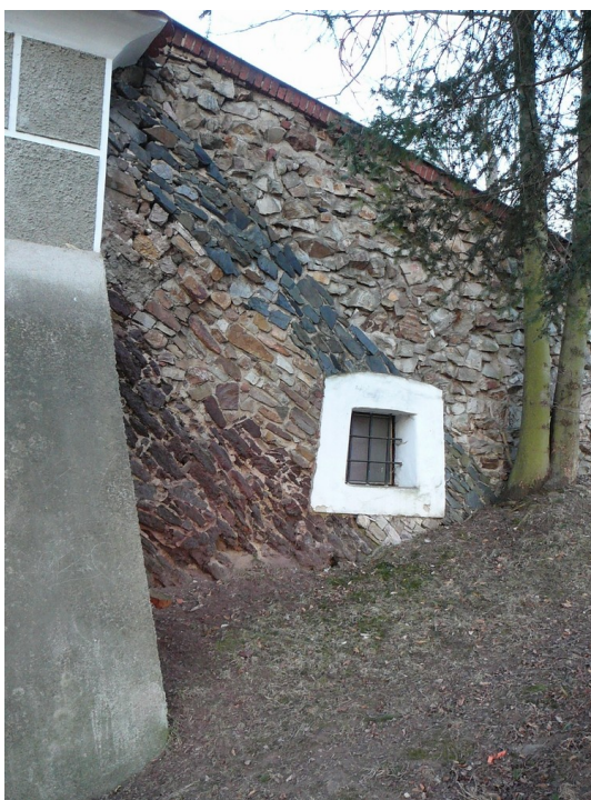
Obr. 15 V roce 1850 byl postaven tento Vstupní portál do dědičné štoly Josef. Na Jeho bočních stěnách je zachycen profil Ložiskem železné rudy.
