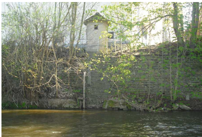
Obrázek č. 18: Bývalá vodoměrná stanice v České Skalici
