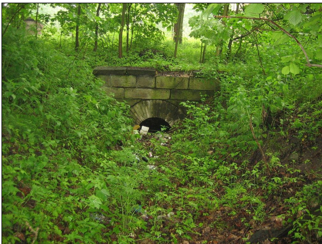
Obrázek 45: Malá propust u silnice k žst. Kamenné Žehrovice (foto květen 2010)
