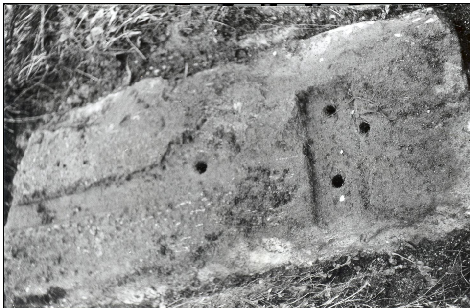
Obrázek 30: Pískovcový podkladový kámen nesoucí stopy po původní tyčové kolejnici s ouškem i po stoličce pro kolejnici širokopatního tvorů, poblíž nádraží Stochov (foto Jan Lisý, poskytl Muzeum TGM – Lány)
