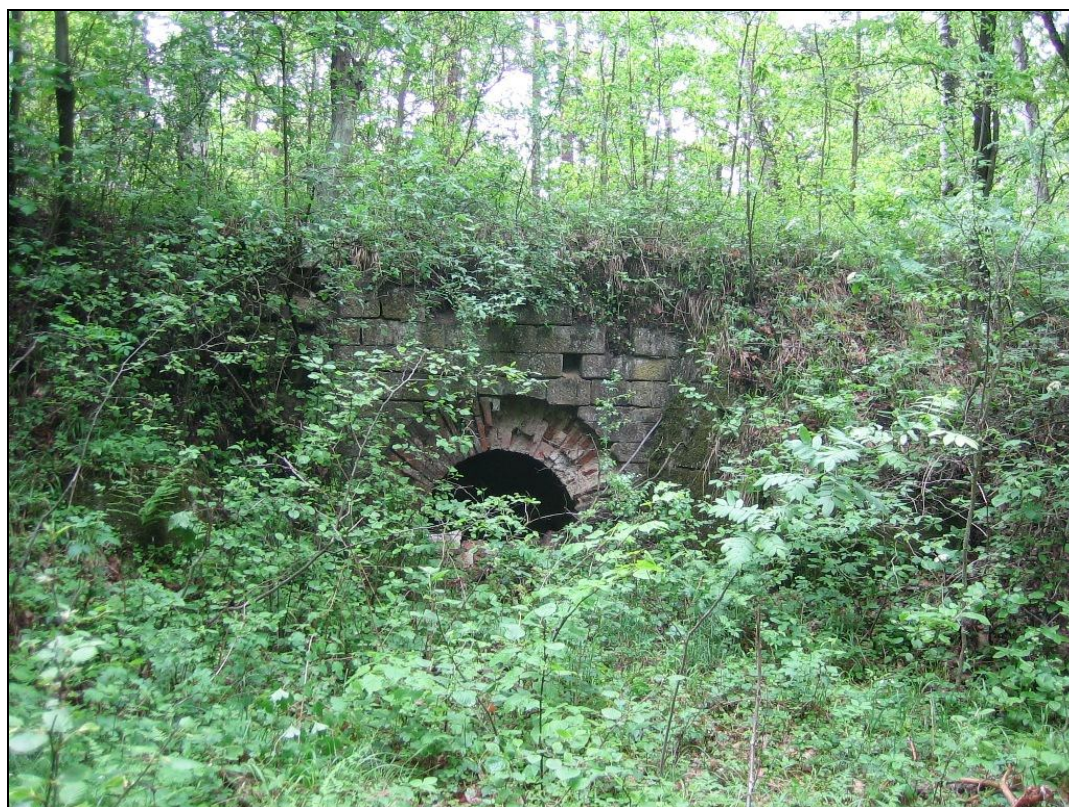
Obrázek 43: Velká propust (foto květen 2010)
