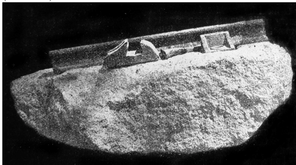
Obrázek 28: Zlomek širokopatní kolejnice s kamenným podkladem a stolička z Pražsko-lánské koněspřežky (převzato z Nechleba 1919)
