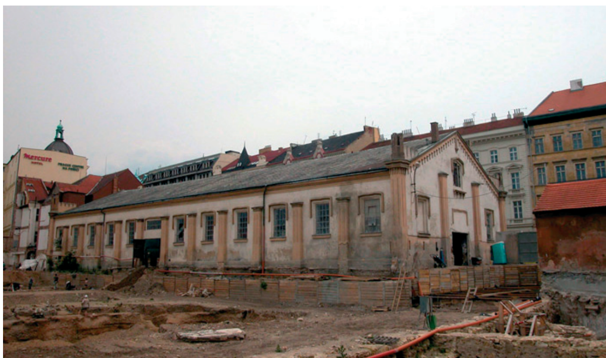
37. Praha – náměstí Republiky, kasárenská jízďárna při pohledu ze severozápadu
