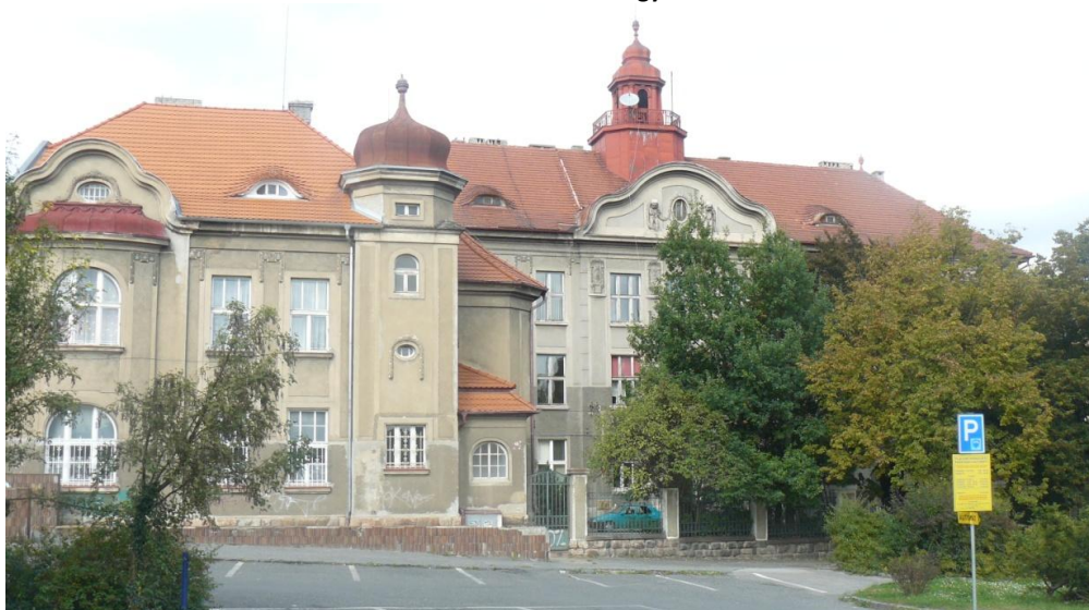
Obrázek 10: Stará budova gymnázia
