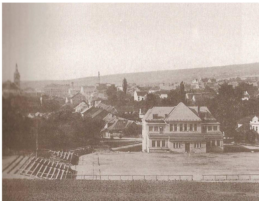
Obrázek č. 4 - Sokolský stadion po dokončení
