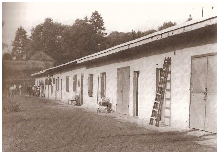
Zdroj: Kronika fotbalového oddílu
