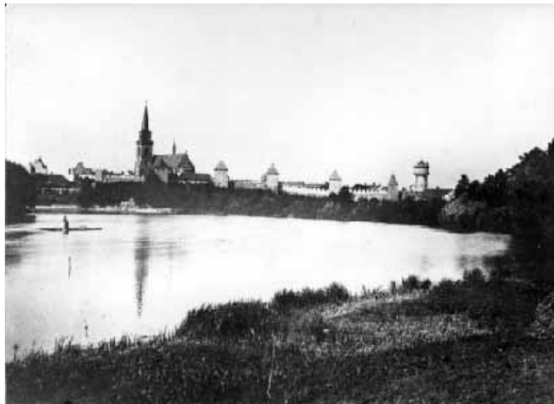
Obrázek 10 - Pohled na město a hradby – Nymburk, kolem roku 1900
