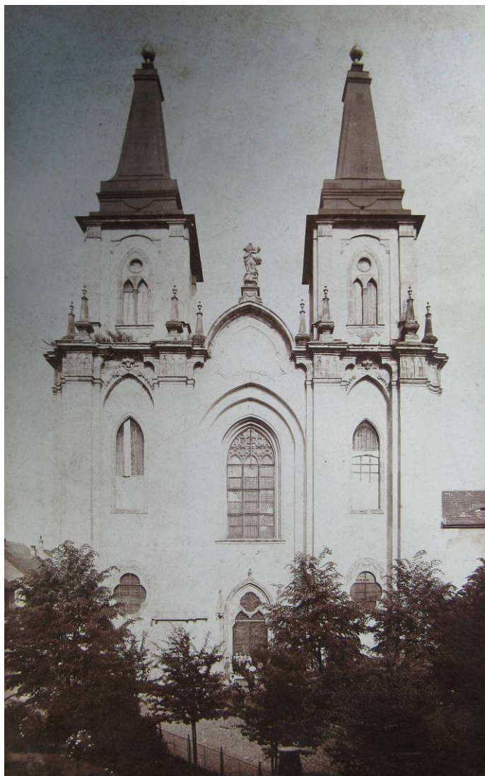
Obr. č. 1. Fotografie západního průčelí, 1898 (ARP, sbírka fotografií)
