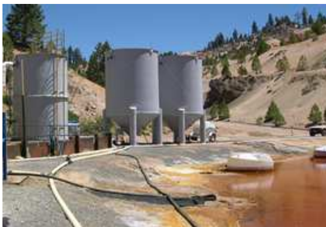
Obr.2.: Aktivní čištění důlních vod vápnem
