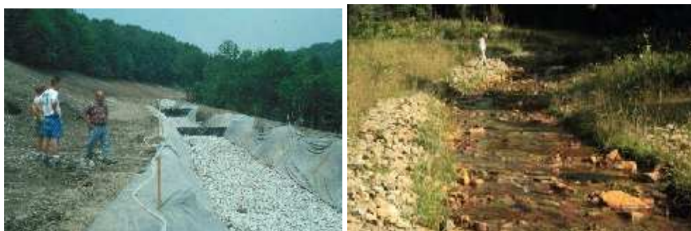
Obr.4.: Pasivní čištění důlních vod – vápencové drenáže
