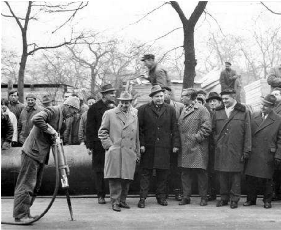
Obrázek 4: Zahájení výstavby podzemní tramvaje v Opletalově ulici
