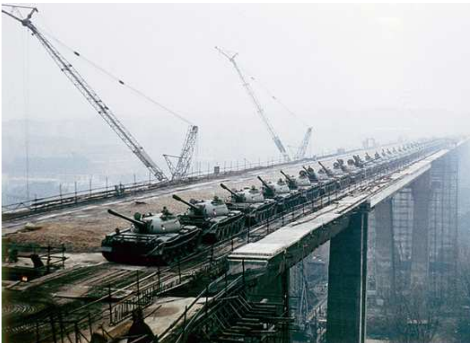
Obrázek 5: Hlavní zatěžkávací zkouška mostu Klementa Gotwalda
